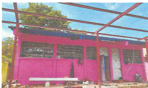
Foto 2: MÓDULO 1 TECHADO DE PATIO
