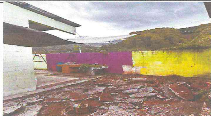
Foto 1: MÓDULO 1 DEMOLICION SEGMENTOS DE LOZA
